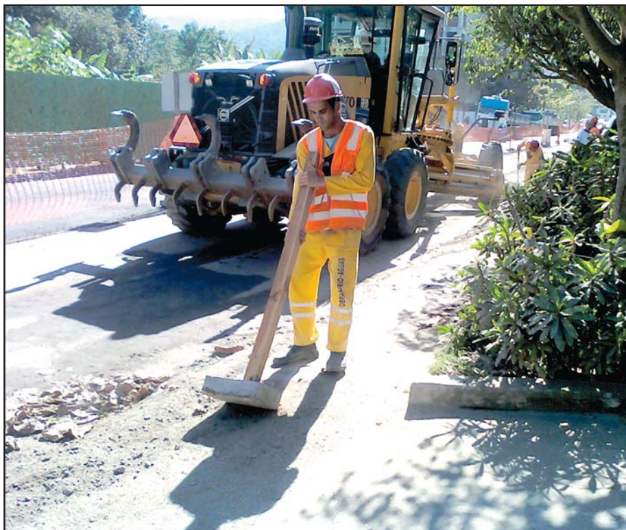
Obras no Capenha geram problemas aos moradores dos imóveis da rua
