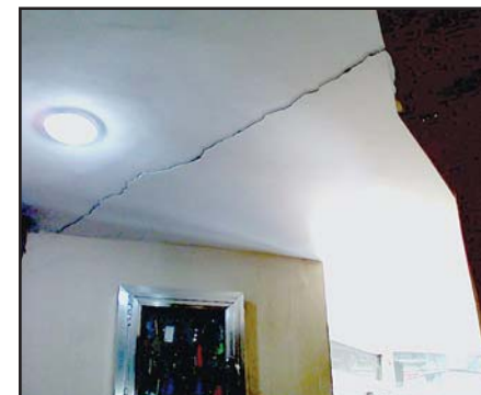
Condomínio Saturno sofre rachaduras
