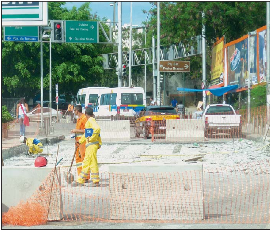
As obras encontram-se sem prazo de conclusão
