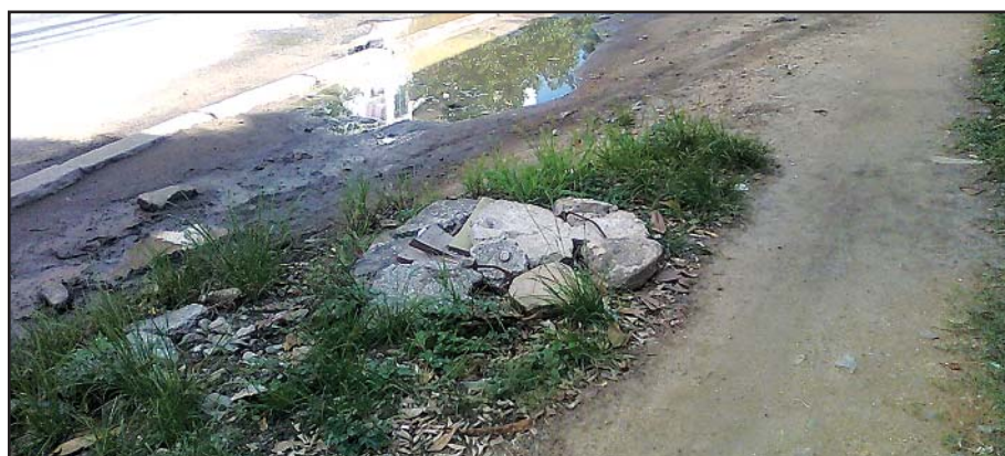
No Tanque também não é difícil tropeçar em algum buraco
