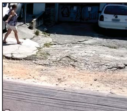
Calçadas no Pechincha têm muitos buracos
